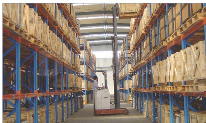
公司立体化仓库
